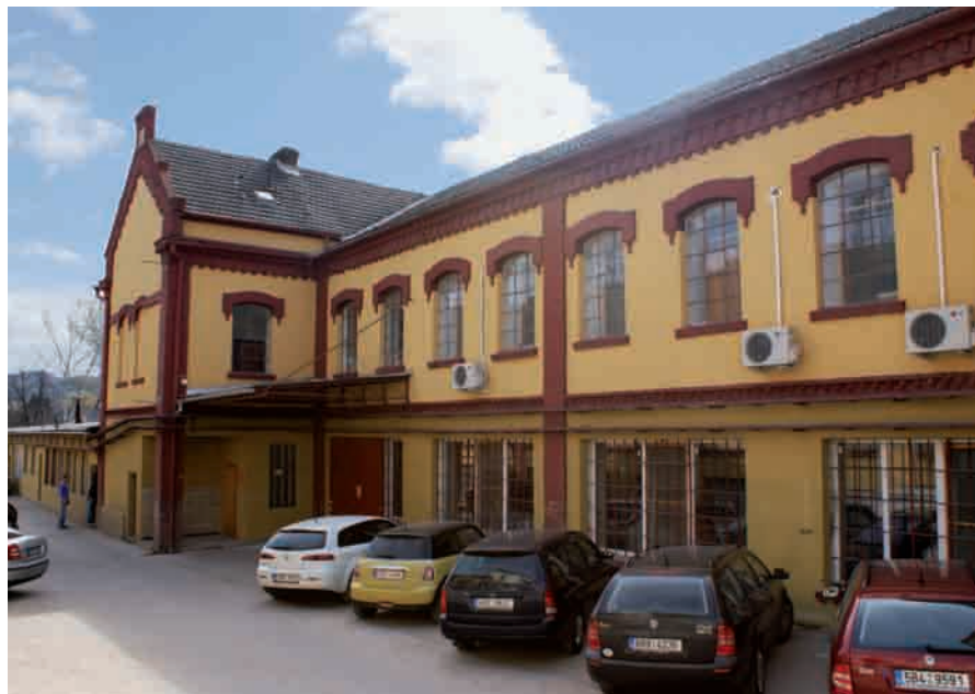
Tiskárna Helbich v Brně, Valchařská 36.
