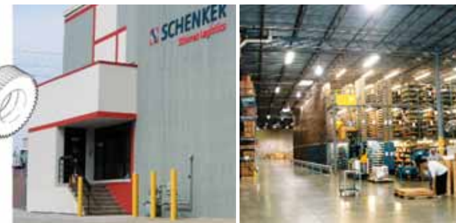
ALC-Eingang und ALC-Innenleben in Indianapolis, USA.
