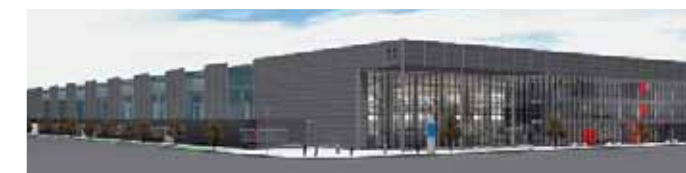
Gigantisch: Auf dem Werksgelände in Wiesloch entsteht derzeit die künftige Herstellungs-Heimat für die neuen 6- bzw. 7b-Maschinen, die Speedmaster XL 142 und XL 162.
