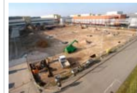
Zuwachs im Werk Wiesloch-Walldorf: Umrahmt von den Hallen 5, 6, 9 und 10, entsteht derzeit die Halle 7, die ab 2009 die Auslegermontage für die Speedmaster SM 102, CD 102 und XL 105 bündeln soll.
